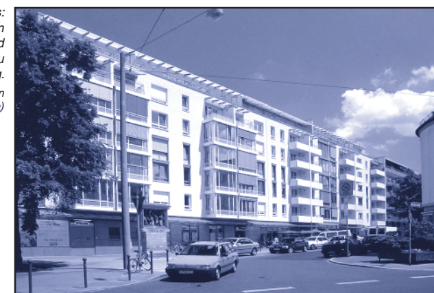
Projektbeispiel Nürnberg St. Johannis: 200 Senioren-Eigentumswohnungen mit Tiefgarage, tragende Innen- und Außenwände in d=15 cm bis zu sechsgeschossig.
