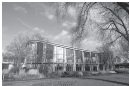
Die Schwarzwaldhalle in Karlsruhe ist der Prototyp der Mehrzweckhalle. Mit ihrer konvex gebogenen, nur knapp 10 cm starken Betonschale setzt sie, am Rande des Stadtparks gelegen, außerdem auch städtebaulich Akzente.
