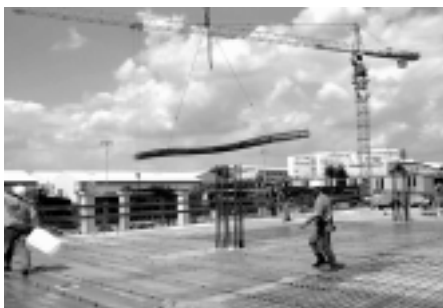
Das anschließende Ausrollen der BAMTEC®-Teppiche können zwei Arbeiter bequem in kurzer Zeit erledigen. Die verlegte Bewehrung stimmt exakt mit dem Plan überein. Ein falsches Verlegen der Bewehrung ist nicht mehr möglich.
