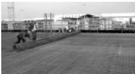
Das anschließende Ausrollen der BAMTEC®-Teppiche können zwei Arbeiter bequem in kurzer Zeit erledigen. Die verlegte Bewehrung stimmt exakt mit dem Plan überein. Ein falsches Verlegen der Bewehrung ist nicht mehr möglich.
