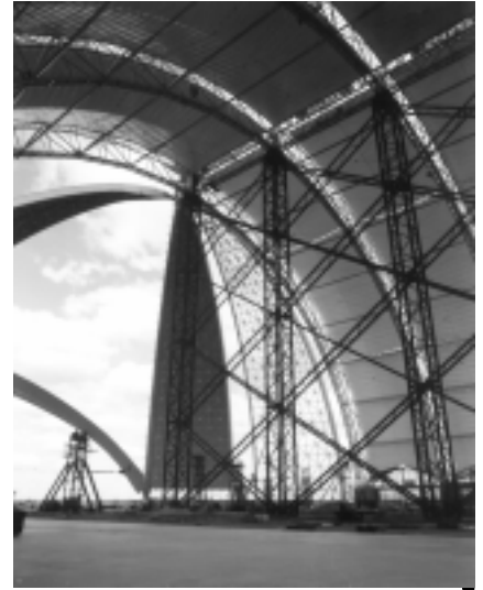
Mit rund 360 Metern Länge, 210 Metern Breite und 107 Metern Höhe entstand bis Ende 2000 die zurzeit größte stützenfrei gebaute Halle der Welt.
