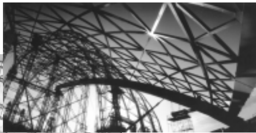
Mit rund 360 Metern Länge, 210 Metern Breite und 107 Metern Höhe entstand bis Ende 2000 die zurzeit größte stützenfrei gebaute Halle der Welt.
