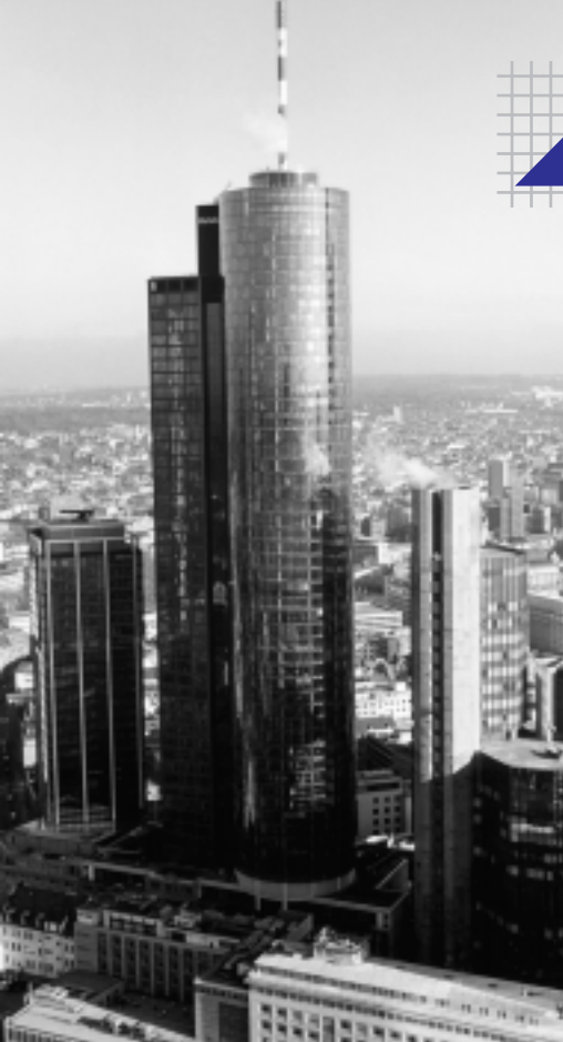
Der MAIN TOWER - das erste öffentlich zugängliche Hochhaus (Höhe 200 m) in Frankfurt. Mit dem Aufzug ist man in 45 Sekunden im Restaurant auf Ebene 56. Die 3,80 m starke Bodenplatte wird von 112 Gründungspfählen getragen, die bis zu 50 m tief ins Erdreich reichen. Für den Rohbau wurden 55.000 m 3 Beton und 17.000 Tonnen Stahl verbraucht. Foto: Helaba (Landesbank Hessen-Thüringen)
