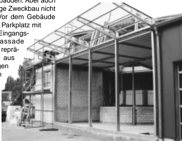
Aus Lkw-Doppelgarage und Verwaltungs-Zweckbau wurde ein ansehnliches Schulungszentrum mit modernster Technik.
