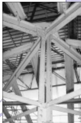
Die Stahlkonstruktion vor der Sanierung
