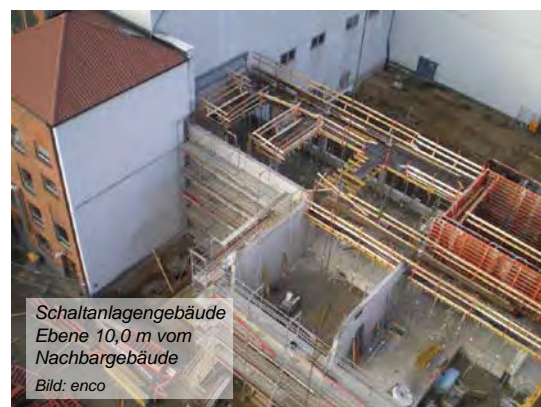
Planung und Ausführung unter äußerst beengten Platzverhältnissen Bild: enco
