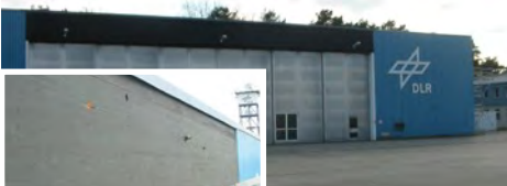
Begutachtung der Brettschichtholzträger der Flugzeughalle des DLR in Braunschweig
