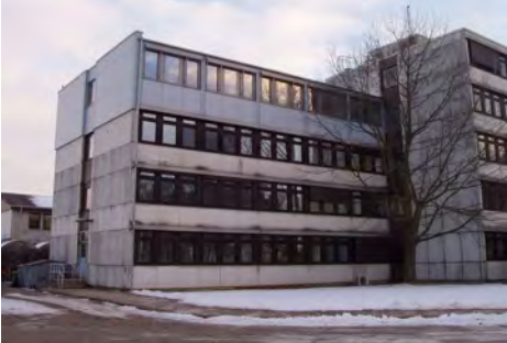
Aufstockung eines Bürogebäudes des DLR Braunschweig in Holztafelbauweise
