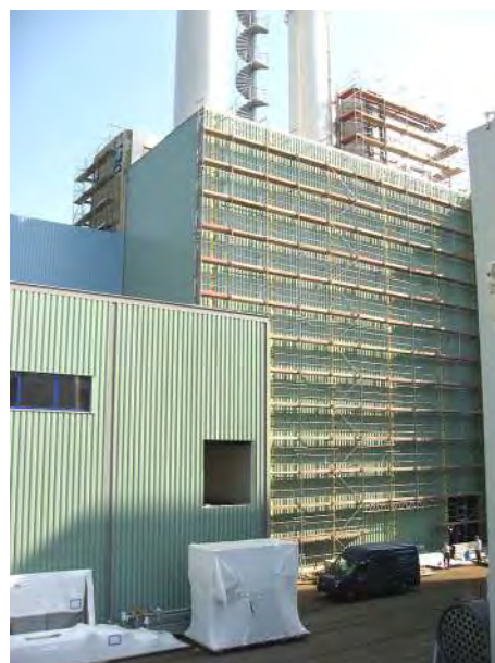
Ende 04/2010: die Fassaden der einzelnen Gebäude sind fast fertig.
