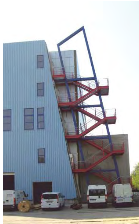
Nordansicht des Maschinenhauses mit Stahl-Schrägstreppe
