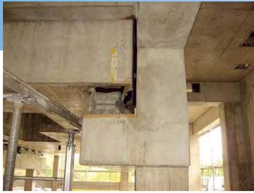
Auflagerung des Turbinentisches im Maschinenhaus
