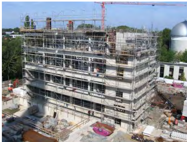
oben: Maschinenhaus mit Massiv-Treppenhaus (Südansicht Ende 08/2009)
