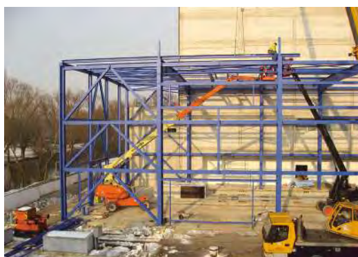
Stahlbauarbeiten am Gasturbinenhaus
