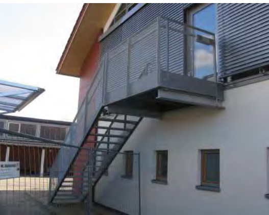
Grundschule Wenden: Sanierter Fassade mit neuer Stahlterasse als Fluchttreppe am Turnhallengebäude.
