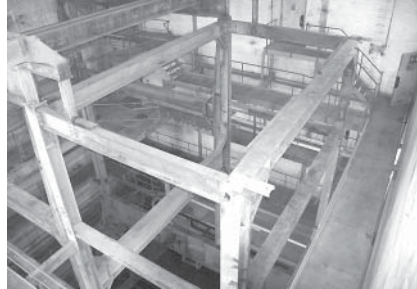
linkes Bild: Ausmauerung Westseite Kessel 11 (nach Sanierung, vor Mauerwerksabbruch) rechtes Bild: Völlig entkerntes Stahlkesselgerüst (im Vordergrund Stahlrahmen für LUVO Luftvorerwärmer)
