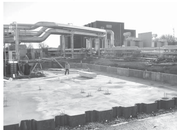
Baugrube für Wasserauffangbecken mit Kühlturm
