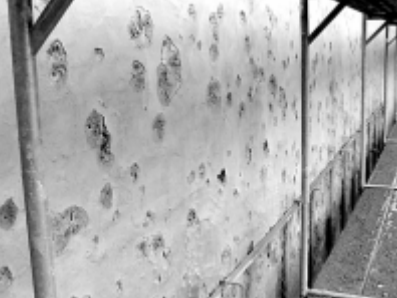
Die von Geschossen "zersiebte" Stahlbeton-Schutzblende
