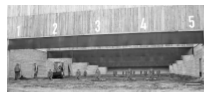
Schießstand nach der Sanierung
