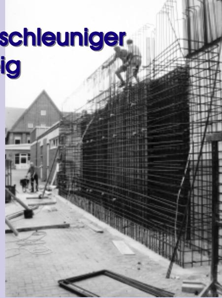
Bewehrung der Außenwand des Linearbeschleunigers: 105 cm Barytbeton, min. 22 cm Blei
